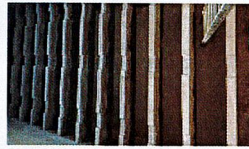
Réfection du génie civil
