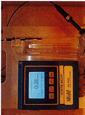
Installation sondes PH analyseurs de chlore amont et aval afin de stabiliser la mesure
