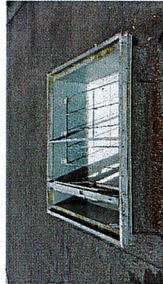
Remplacement des trappes de désenfumage
