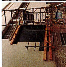
Création des ouvertures
