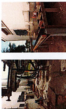
Réalisation des micros pieux pour la dalle des transformateurs HT
