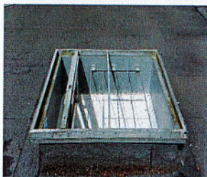
Remplacement des trappes de désenfumage
