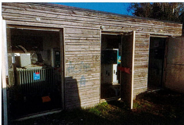
Travaux de renforcement des portes du local transformation avec plaques inox 3mm d'épaisseur
