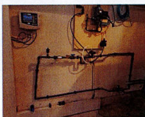
Modification de la chloration – surpresseur de Gretz-Armainvilliers
