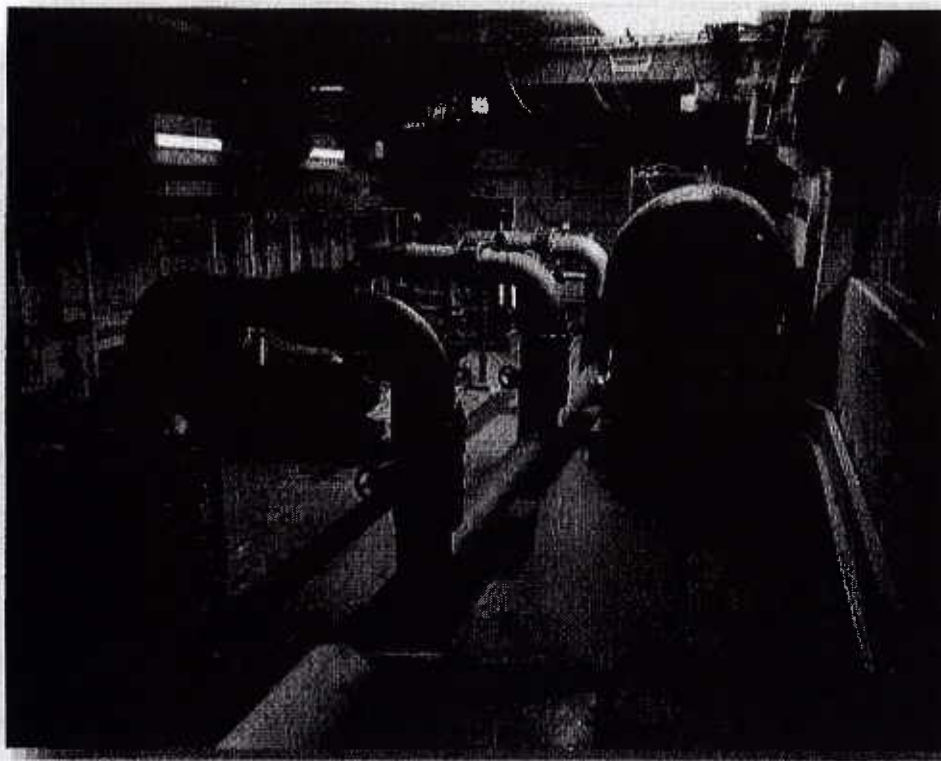
Intérieur de la station de reprise de Gretz
